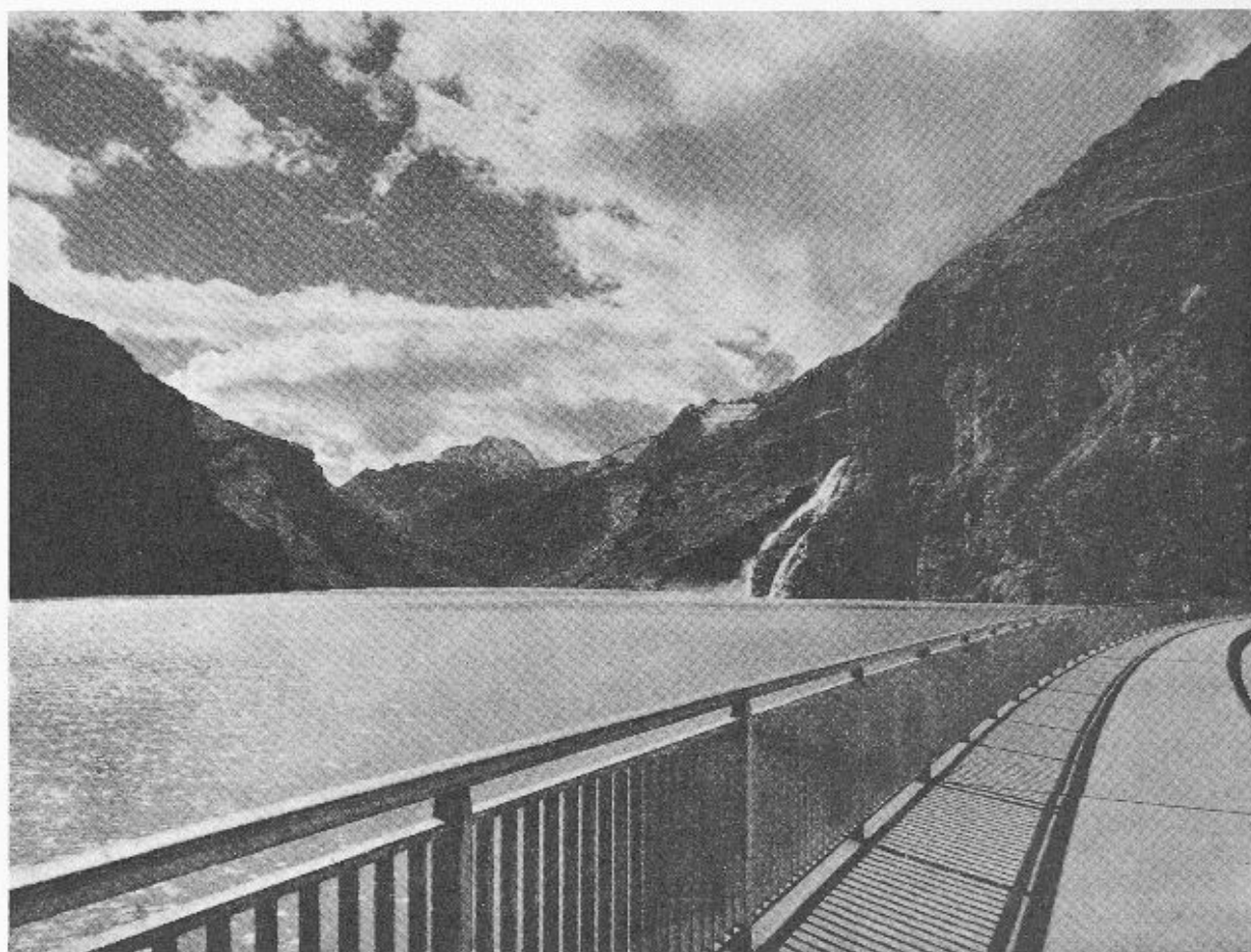
Fig. 8. — Le lac de Mauvoisin vu du barrage.
