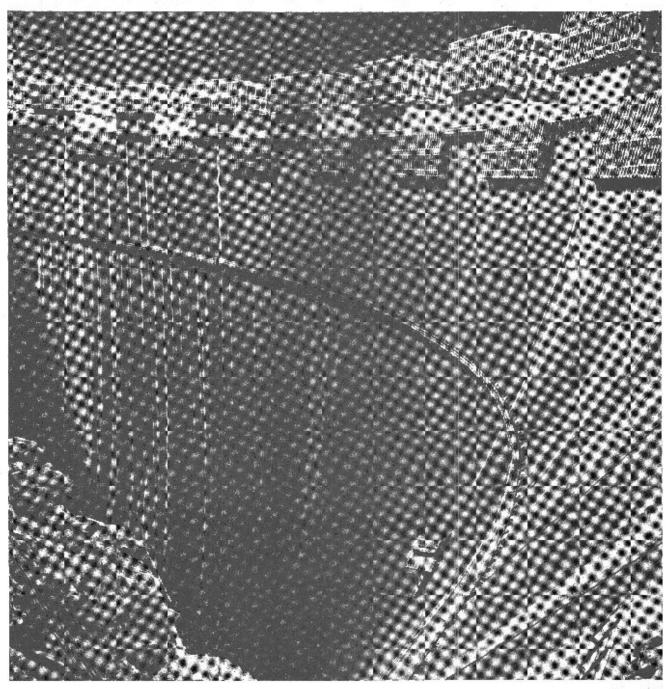
BARRAGE DE MAUVOISIN Hauteur: 237 m Cube de béton: 2 050 000 m3
