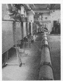
Fig. 13. — Conduite d'adduction Ø 300 mm avec section de jaugeage par diaphragme (vue depuis l'aval).
