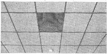
ULTRACOUSTIC dalle accustique non perforée, incombustible, ici posée, sur rails visibles
