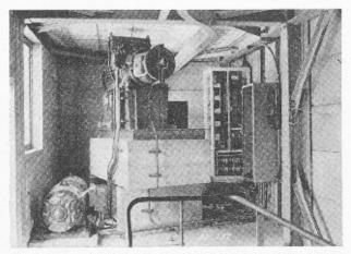
Salle des machines d'un ascenseur sélectifcollectif à Ward-Leonard. Au fond, à droite, armoire comportant l'automatisme et les organes de régulation. A droite, à l'avant, boîtier d'appareillage pour le groupe.
