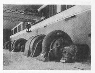
Fig. 3. — Centrale de Stafel, de Grande Dixence, équipée de trois pompes-turbines, d'une puissance unitaire de 10 000 CV.
