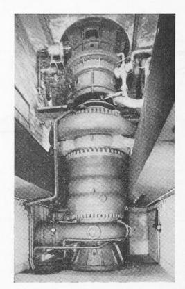
Fig. 15. — Vue d'ensemble d'une des pompes avec accouplement hydraulique,
