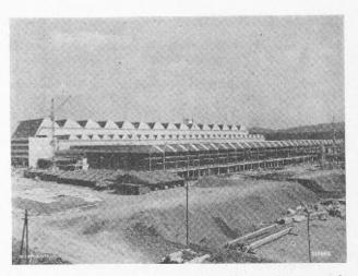
Vue d'ensemble du chantier de Birr. En complément à la première étape de construction (les grandes halles à l'arrièreplan) est couverte une surface de 24 000 m<sup>8</sup> à l'aide de 148 sheds préfabriqués. Les halles de la deuxième étape de construction apparaissent au premier plan.
