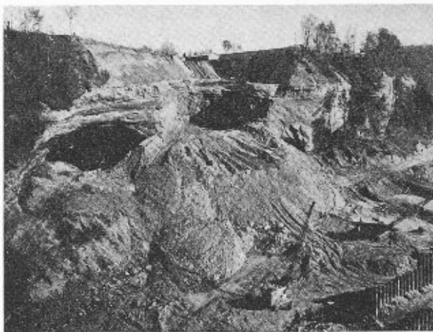
Fig. 10. — Deuxième étape. Excavation de la culée rive gauche.
