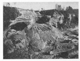
Fig. 10. — Deuxième étape. Excavation de la culée rive gauche. (Photo Mülhauser, Fribourg.)
