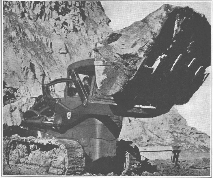
La prestation de travail du conducteur est nettement plus grande parceque, placé à l'avant, il peut exactement contrôler la pointe du godet. Malgré son poids de 13 tonnes, cette machine est conduite hydrauliquement - du bout
