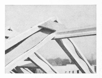
Fig. 3. — Jonction des chevrons sur le faîte.
