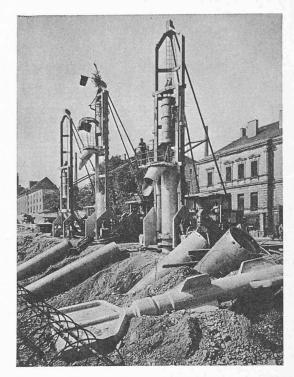
Fig. 2. - Machine Benoto « EDF 55 ».
