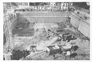
Fig. 15. - Enceinte de fouille Radio-Munich.
