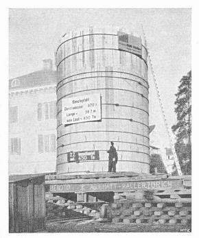
Fig. 7. — Essai de charge 450 tonnes, chantier « Palme ».
