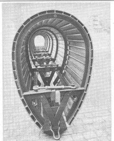
Coffrage déployable pour le réseau de canalisation à Zurich, section standard
