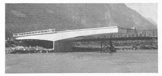
Fig. 4 a. — Demi-pont vu de côté.
