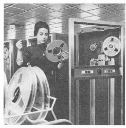
Fig. 4. — Unité de bande magnétique IBM 729 - I.
