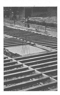
Pour coffrage de dalles tout à fait plane Langues d'appui rétractables Dessus très large Réglage facile Robuste
