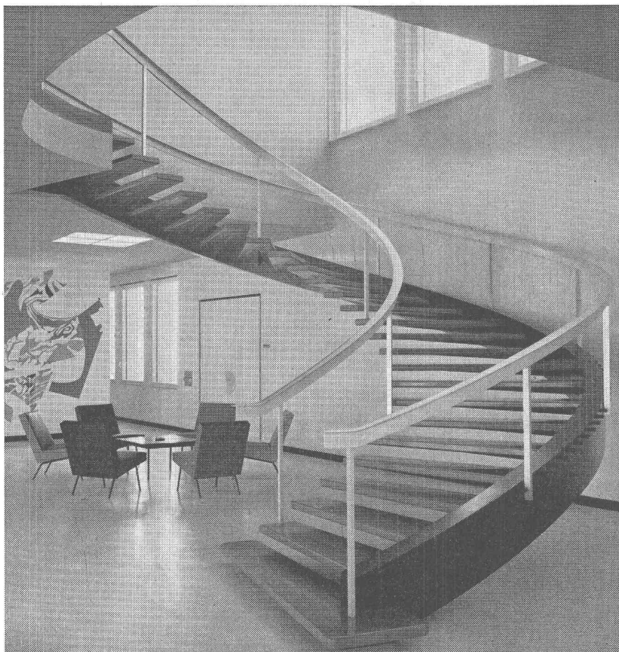
Escalier métallique avec rampe en métal léger.
