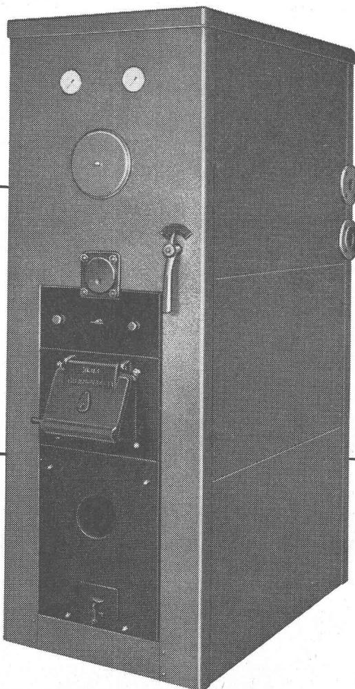
De l'eau chaude — toujours à bon marché chaudière combinée D E ROLL type V-Rt, en fonte. Puissance 27000—156000 kcal/h. Production d'eau chaude 225 — 1 575 l/h 60° C
