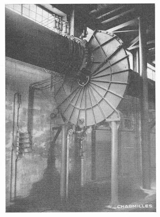
Fig. 19. — Porte-diaphragmes du circuit basse chute.
