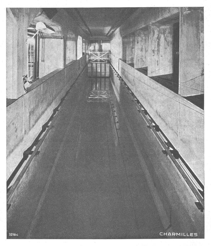
Enduit étanche au SIKA-1 et glaçage de précision exécutés par l'un de nos spécialistes. Largeur moyenne du canal (36 points de mesure) : 1919,5 mm Ecart maximum absolu  $\pm$  0,4 mm. Ecart moyen :  $\pm$  0,07 mm.
