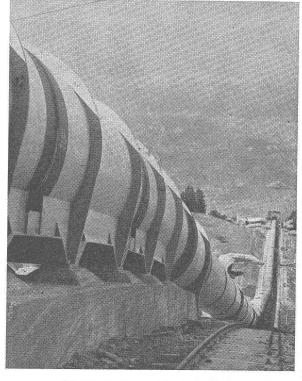
Conduite forcée en plein air de Nendaz de la Grande Dixence S. A., en montage. — Dlamètre 3150 mm. Pression maximum d'essai en atelier 84 atm.
