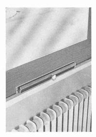
Fig. 1. — Fente d'admission d'air extérieur avec soupape réglable.
