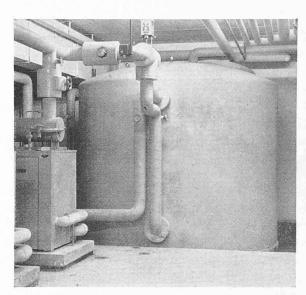
Fig. 5. - Accumulateur d'eau glacée.
