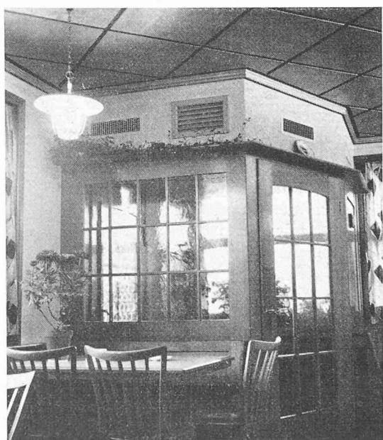
étant pourvue d'un filtre à graisse. Sous le plafond sont encore aménagées diverses petites bouches d'aspiration qui évacuent continuellement les fumées. En été, l'installation fonctionne comme aérateur; dans les périodes d'entre-saison, un réchauffeur électrique de l'air assure une température confortable.
