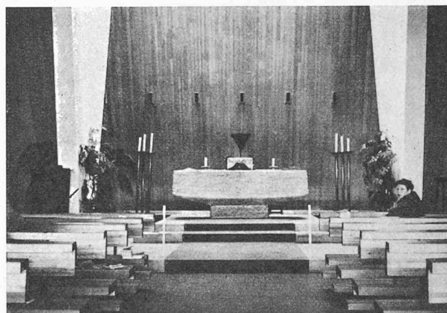
La figure 2 montre l'autel et la face arrière, où l'on distingue nettement cinq des neuf tuyères de pulsion installées. On constate que ces tuyères, qui s'incorporent parfaitement au caractère de l'édifice, sont tout à la fois un élément fonctionnel et décoratif.
