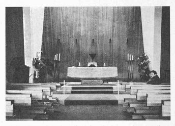
La figure 2 montre l'autel et la face arrière, où l'on distingue nettement cinq des neuf tuyères de pulsion installées. On constate que ces tuyères, qui s'incorporent parfaitement au caractère de l'édifice, sont tout à la fois un élément fonctionnel et décoratif.
