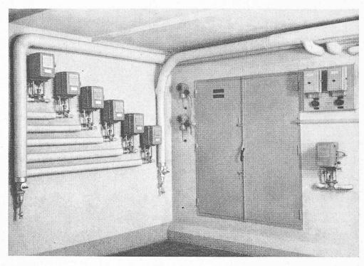
Fig. 18. — Vannes des réchauffeurs secondaires. Au milieu : thermostats à point de rosée « hiver-été ».
