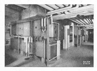
Fig. 8. — Appareils de climatisation dans les combles, réservés à cet effet, au-dessus des salles d'opérations.
