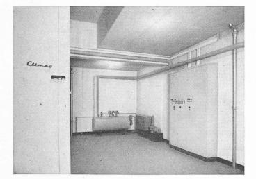
Fig. 10. — Local des appareils dans le vide de toiture. A droite, les panneaux de contrôle, avec l'appareillage électronique. A gauche, vue partielle de l'un des deux agrégats de climatisation. A l'arrière-plan, le générateur électrique de vapeur et la pompe d'alimentation.
