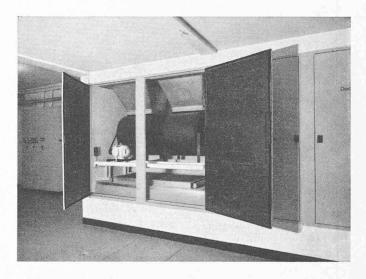
Fig. 18. — Agrégat de pulsion dans le local des appareils, situé dans le vide de toiture. Cet agrégat est destiné à la ventilation du vide de toiture. Les portes d'accès à l'autre agrégat sont ici fermées.
