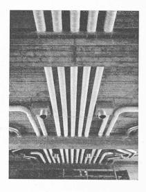
Fig. 16. — Système de distribution des tuyaux de pulsion d'air climatisé pour la salle des conférences (photo prise pendant les trayaux).
