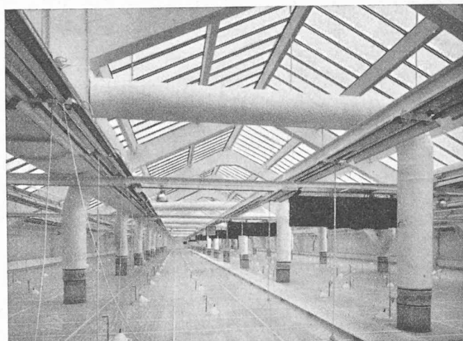
Fig. 13. — Le vide de toiture, avec le réseau de distribution des gaines d'air climatisé ; les raccords sont en matière transparente. En haut, à gauche, vue partielle d'un gros amortisseur de bruit.
