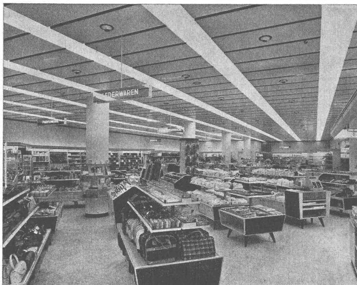
Grands Magasins « Innovation » à Brigue Distribution d'air climatisé par le plafond
