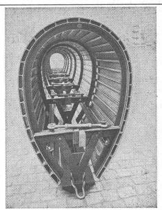
Coffrage déployable pour le réseau de canalisation à Zurich, section standard
