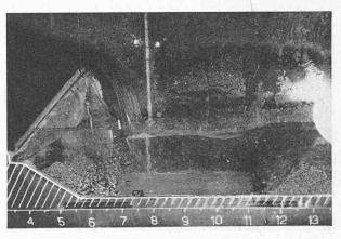
Fig. 32. — Radier sans dispositif de purge. Redressement du clapet après une crue de 300 m³/sec.
