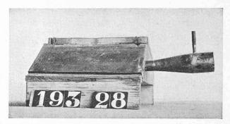
Fig. 19. — Fente de purge au bas du radier. La vanne est démontée. A droite, l'alimentation de la purge.
