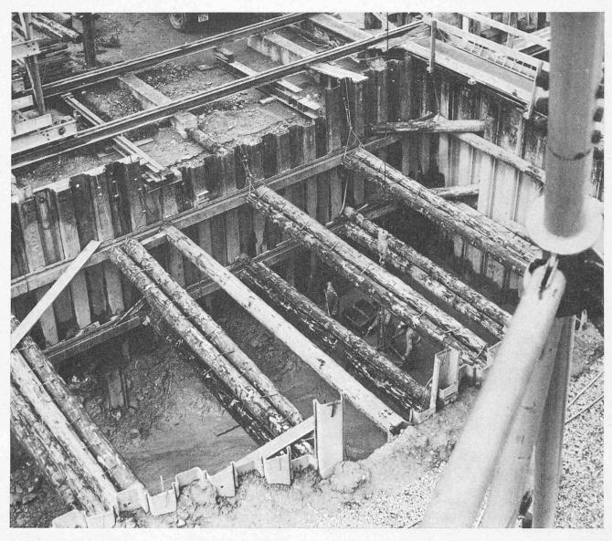
Fig. 15. — Terrassement pour les conduites souterraines enrobées de béton; fouille blindée de la deuxième cellule.
