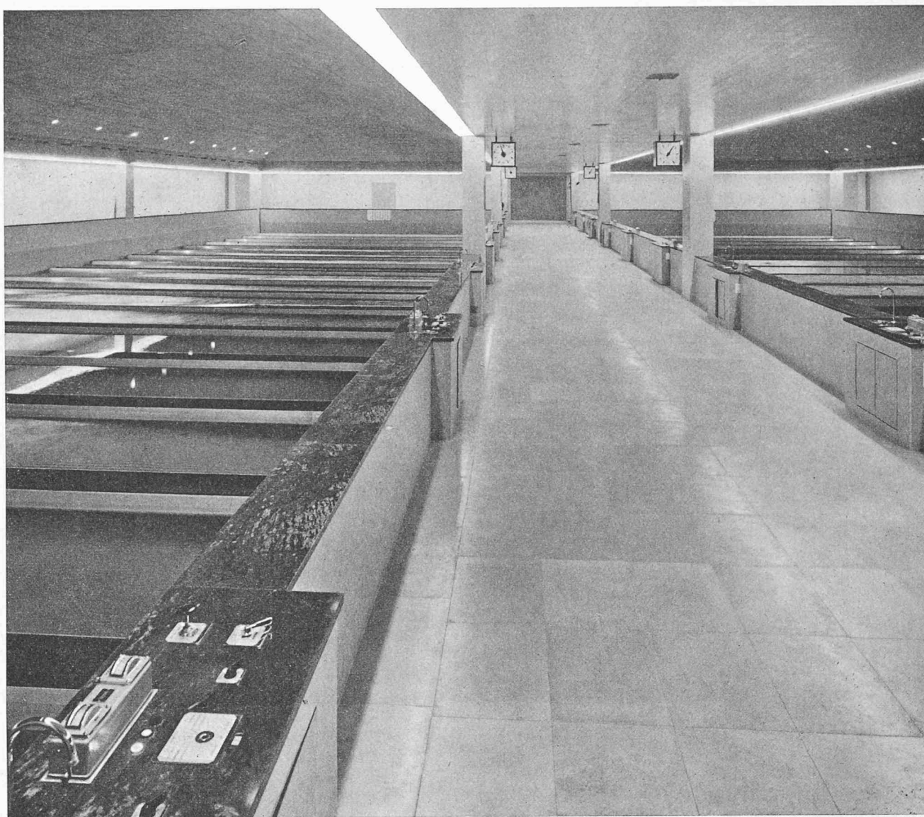
Fig. 8. — Vue générale de la salle des filtres ; des deux côtés de la galerie centrale, on distingue les pupitres de commande.
