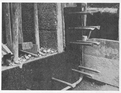
Fig. 14. — Détail d'un joint de la galerie; on distingue les goujons, la plaque de liège et la bande étanche.
