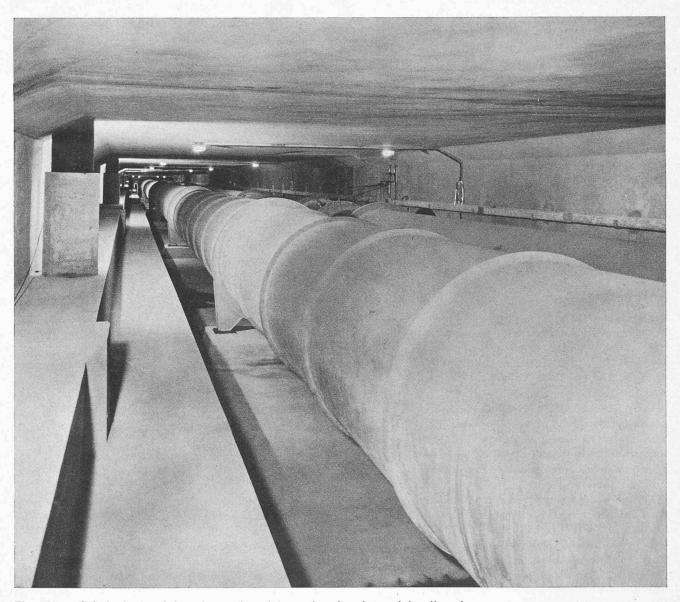
Fig. 12. — Galerie des conduites rive-station. Au premier plan, la conduite d'eau brute.
