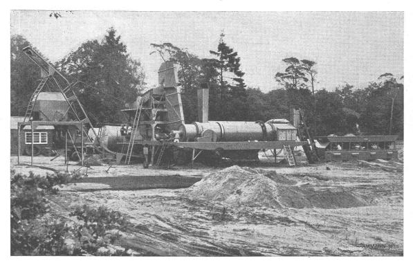
Poste d'enrobage type 1000 SB, capacité 38 à 45 t/h
