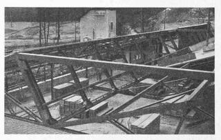
Fig. 11. — Montage des plaques Durisol en cours à une extrémité du bâtiment, alors que le montage de l'ossature n'est pas encore entièrement terminé.
