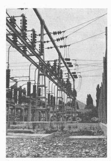
Fig. 4. — Sion, 1954. l=7 m ; H=3 t ;  $k_2=28.6 \text{ kg/m}^2$  ; T=65 kV.
