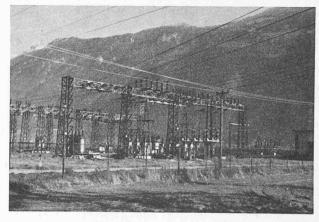
Fig. 1. — Vorziers, 1929. Portées max., l=8 et 9 m. Efforts de traction par câble au départ des lignes, H=3 t. Poids d'acier au m²,  $k_2=32$  kg/m². Tension, T=65 kV.
