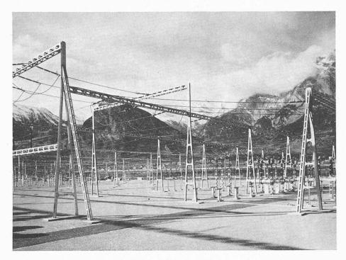
Fig. 9. — Chamoson, 1959.  $l = 17 \text{ à } 21 \text{ m }; \ H = 5 \text{ t }; \\ k_2 = 12.8 \text{ kg/m}^2; \ T = 220 \text{ kV}.$  Photos Vulliemin et Dorsaz, Lausanne.
