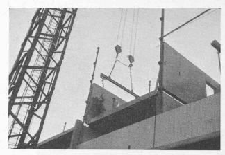
Fig. 7. — Mise en œuvre. Agrafage des pièces sur mannequin métallique.
