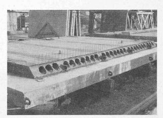
Fig. 5. — Dalle alvéolée avec poutrelles incorporées.
