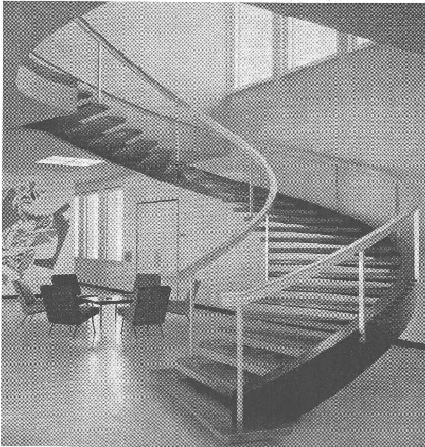
Escalier métallique avec rampe en métal léger.
