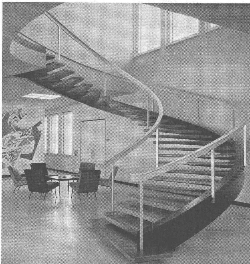
Escalier métallique avec rampe en métal léger.
