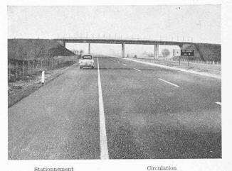
Fig. 4. — Première phase du revêtement. Couche de support d'enrobés bitumineux livrée à la circulation. Les deux couches de tapis seront posées ultérieurement.
