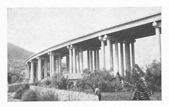
Fig. 2. — Viaduc Marinella. Quinze travées à deux appuis simples, de portée 30 m, en béton armé, construites en place sur échafaudage.
