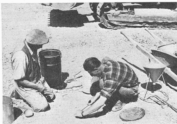
Photo n° 9. — Détermination de la densité sur place.
