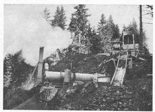
Photo nº 5. — Installation de séchage des terres.
