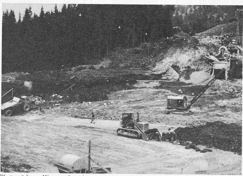
Photo nº 6. — Mise en place des terres. Au premier plan, élimination des grosses pierres. Au deuxième plan, la grue dameuse en action.
