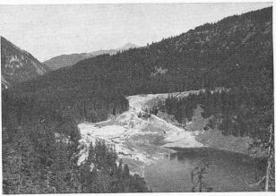
Photo nº 4. — Vue générale du chantier montrant la position de la digue par rapport aux terres d'emprunt situées au milieu en haut de la photo.
