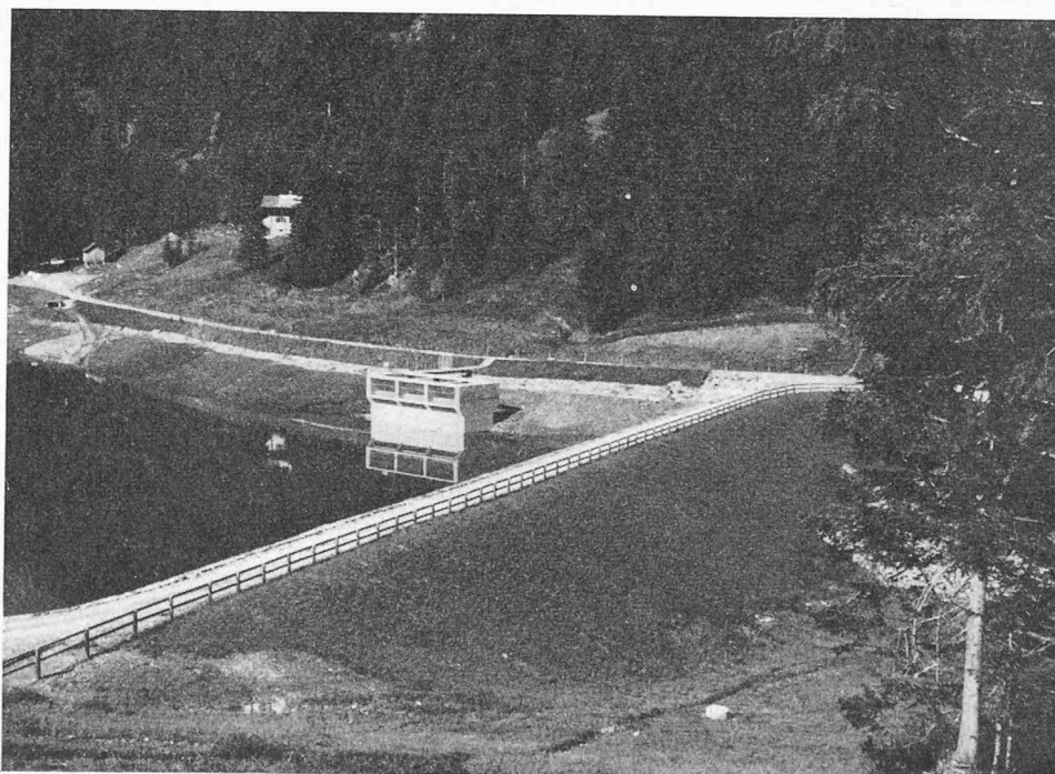
Photo n° 1. — Vue générale de la digue et de l'évacuateur de crues.
