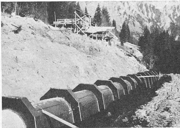
Photo n° 2. — Galerie de l'évacuateur de crues.
