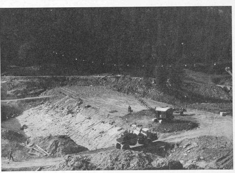
Photo nº 8. — Vue de la digue et du perré en construction.
