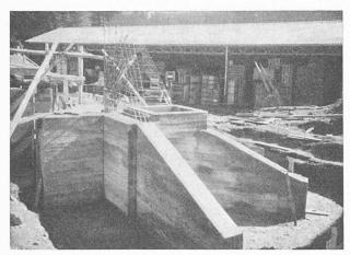
L'un des massifs d'appui du paraboloïde.
