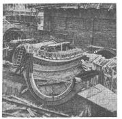
en caoutchouc synthétique ou PVC mou. Etanchéité parfaite des joints de dilatation des ouvrages en béton Des arrêts de joints Meyco au chantier Usine électrique de Schongau a. Lech
