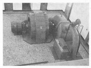
Fig. 22. — Groupe hydro-électrique de 5300 kVA.
