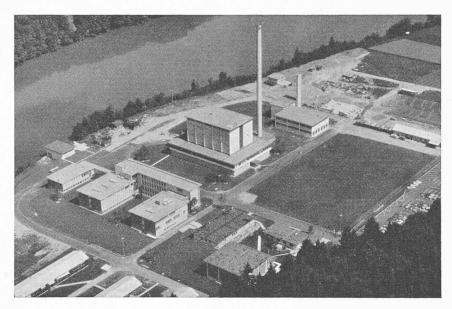
Fig. 1. — Vue des installations de Würenlingen. (Au centre le bâtiment du réacteur « Diorit », à gauche les ateliers et laboratoires, en bas le bâtiment du réacteur « Saphir », en haut l'Aar.)
