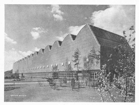
Fig. 1. — La nouvelle usine Brown Boveri à Birr, vue de l'est. La photographie montre la principale des trois halles de montage contiguës, longues de 270 m; sa hauteur est de 32 m et sa largeur de 36 m.
