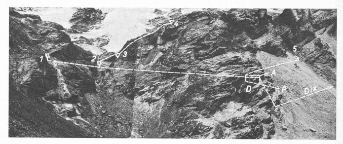
Fig. 2. — Vue panoramique de l'ensemble du captage. 1, 2 et 5 : torrents avec prises d'eau ; 3 et 4 : torrents déviés vers la prise 2 ; D : dessableur ; A : galerie d'accès au dessableur ; P : galerie de purge ; DIX : galerie Vouasson-Dixence.
