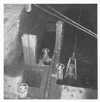
Fig. 7. — Vue partielle du système de «commande de purge par palpage». De gauche à droite: le puits 5, l'horloge hydraulique 2 alimentant le bassin 3, l'horloge hydraulique 11 alimentant le bassin 12, la vanne 10 et le siphon 13.
