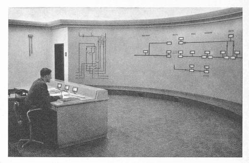
Fig. 3. — Centrale de surveillance de l'installation de distribution de gaz des charbonnages de l'Etat néerlandais.
