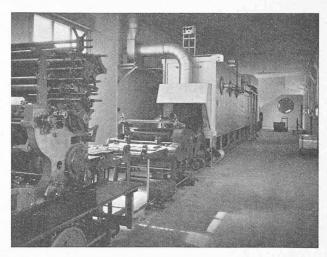
Fig. 7. — Installation de séchage et de cuisson des vernis sur tôles d'emballage (chauss'age par convection).
