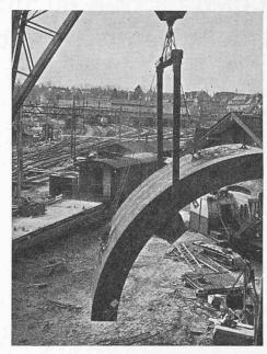
Fig. V/3. — Mise en place d'un élément du bouclier dans le puits à l'aide d'une grue C.F.F. de 25 t.
