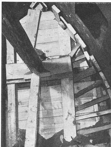
Fig. V/7. — Etayage du front d'attaque, sous le faite.
