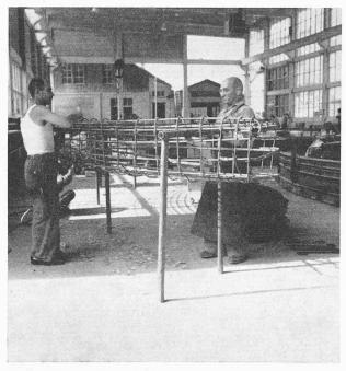
Fig. IV/13. — Montage des armatures des voussoirs.
