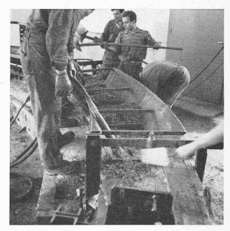
Fig. IV/15. — Bétonnage d'un anneau.
