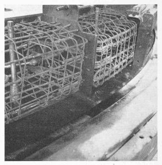
Fig. IV/14. — Détail d'armature aux joints.
