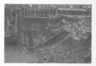
Fig. 3. — Glaise postglaciaire en cours d'excavation.
