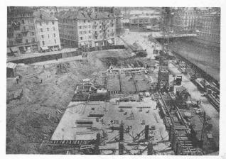
Fig. 1. Vue d'ensemble des fondations en cours d'exécution.
