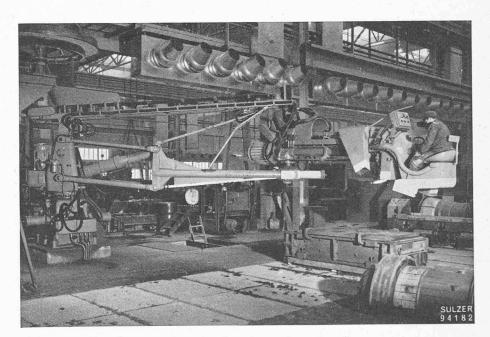
Fig. 9. — Sandslinger stationnaire dans le moulage des pièces moyennes.
